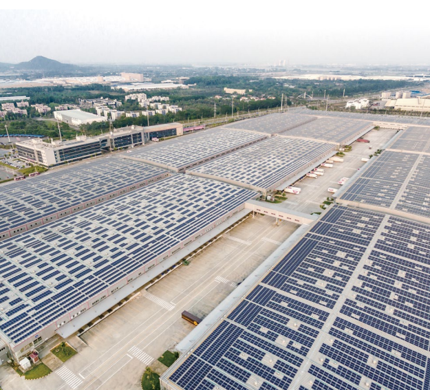
物流园光伏电站
